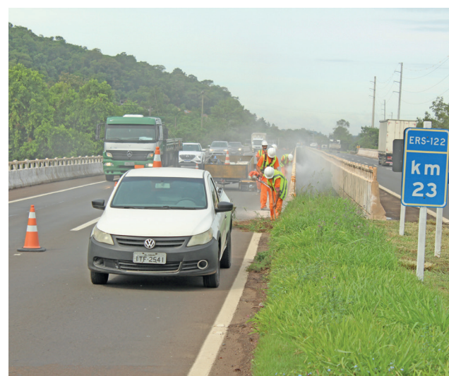
Obras na ponte sobre o rio Caí, na Bela Vista: manutenção e reforço na sinalização
